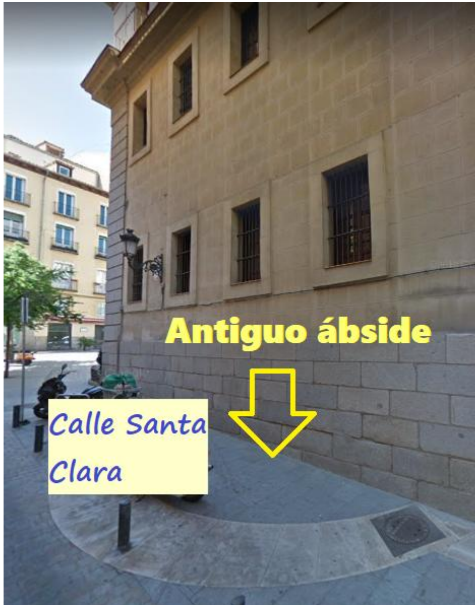
Vórtice telúrico en el antiguo ábside de la iglesia de Santiago, señalado en el pavimento de la calle Santa Clara
